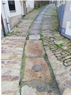
P.03. PAVIMENTO TRADICIONAL DA RÚA DA PONTE
